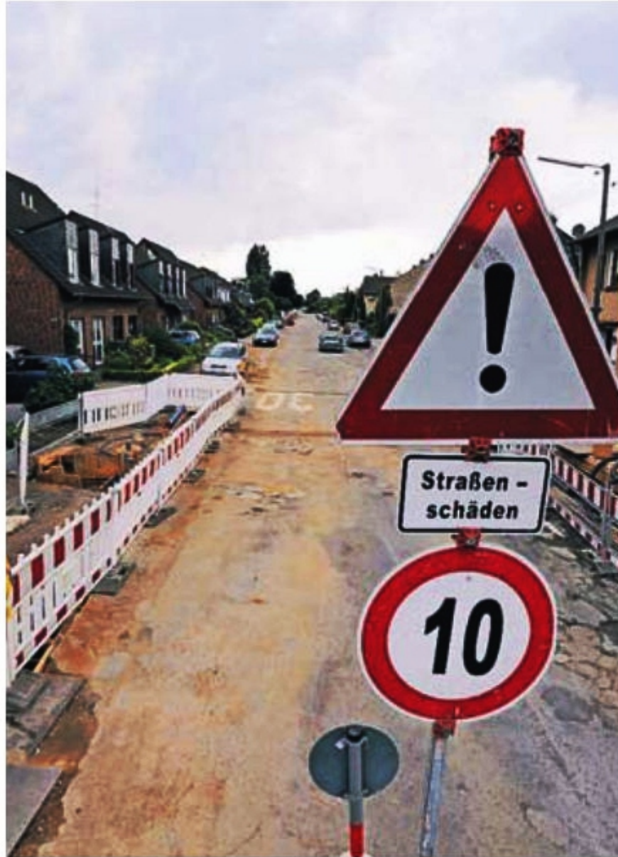
Kein schöner Anblick – noch! Mit dem für diese Woche geplanten Spatenstich für den Umbau der Ringstraße startet die Gesamtanierung für Hitdorf.
